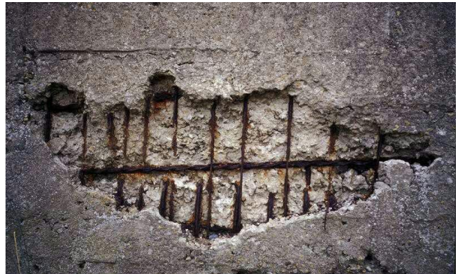
Fig. Spalling
